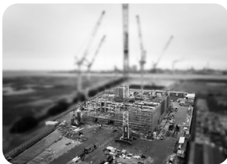
第2期君津地域広域廃棄物処理施設の建築工事状況（令和7年3月8日時点）
