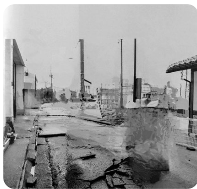
能登半島地震の被害の様子
