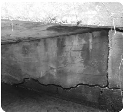
経年劣化により構造体に亀裂が生じている様子
