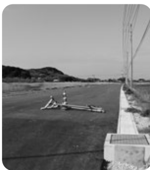
道路の利便性を向上させるため整備中の市道下飯野線
