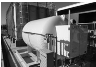
現在、建設されている君津市給食センターに設置される石油ガス災害バルク（平成31年4月運用開始予定）
