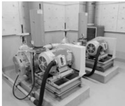
浄化槽内に空気を送り微生物を元気にするための機器(曝気ブロー)を交換
