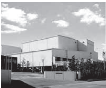
君津地域4市の一般廃棄物中間処理施設である(株)かずさクリーンシステム
