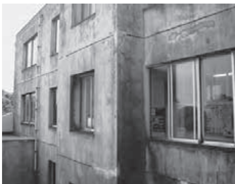
老朽化が進む小学校校舎
