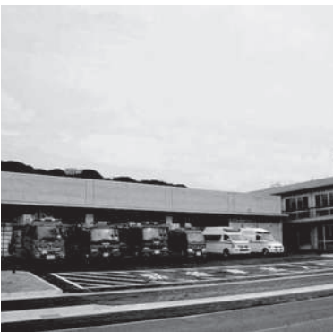
消防防災センター
