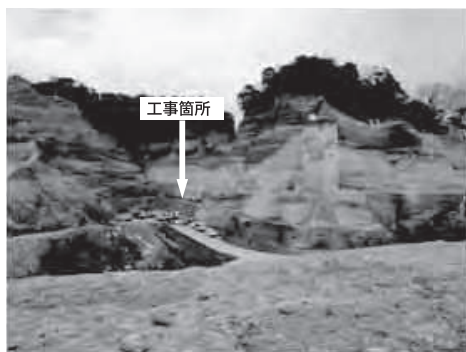
大平興産(株)第2処分場 漏えい地層に遮水シート敷設工事(今年1月30日撮影)
