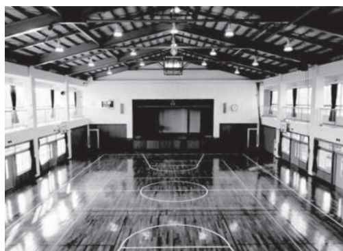
耐震補強工事が完了した湊小学校屋内運動場
