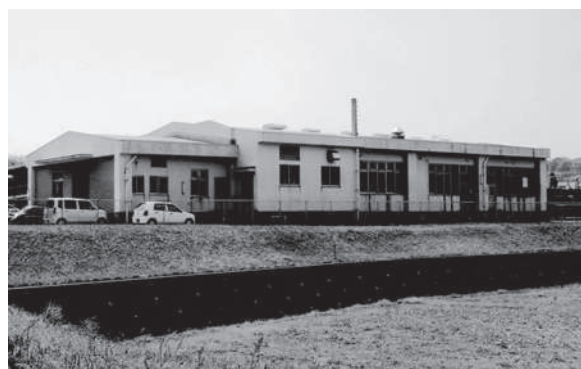
工事が予定されている大貫共同調理場
