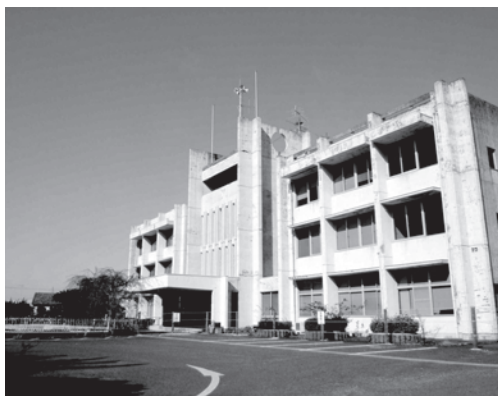
旧天羽行政センターの現況
