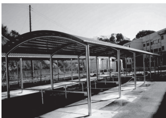
新築した大貫中学校自転車置場
