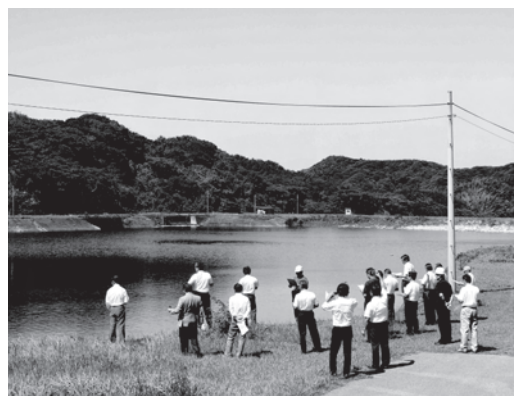
現地視察した小久保ダム
