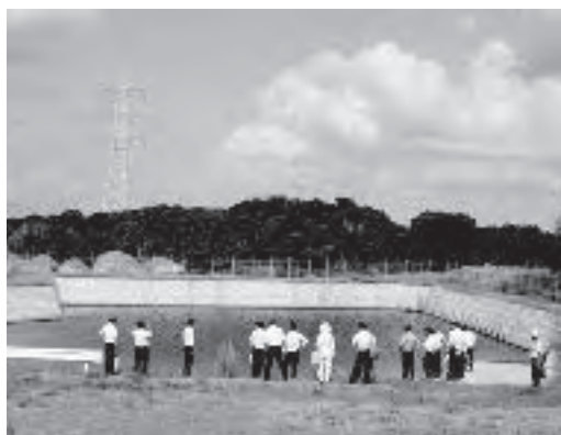
現地視察した消防防災センター敷地内調整池
