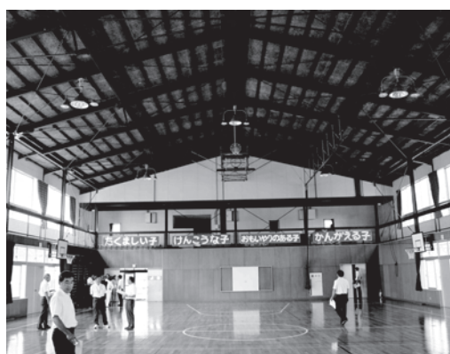
現地視察した耐震補強後の竹岡小学校体育館
