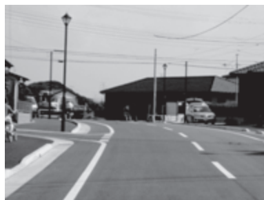
市道青堀駅東口第1号線
