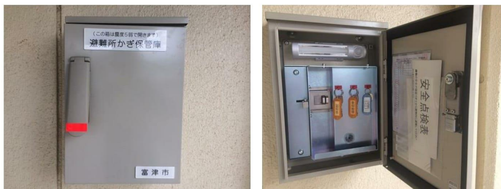
設置場所：青堀小学校、富津中学校、大貫中学校、天羽中学校の体育館の入り口付近
