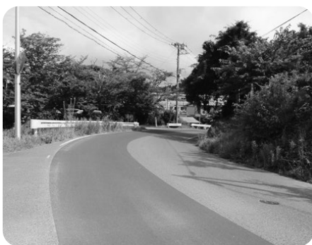
区画線設置、滑り止め舗装等を実施する市道湊数馬線
