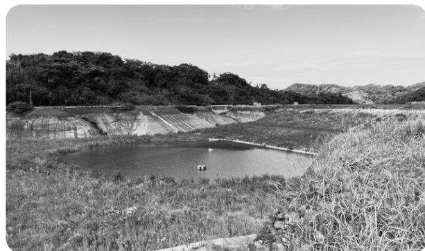
キャンプ場、イベント会場などに活用される旧小久保ダム
