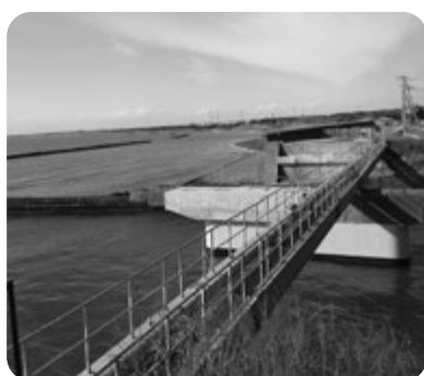
橋梁長寿命化修繕事業による岩瀬海岸橋架け替え工事
