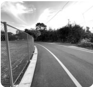
道路整備が完了した天羽中学校付近
