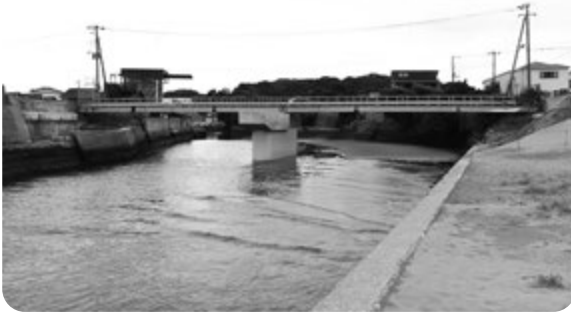
修繕工事中の市道海岸線海岸橋
