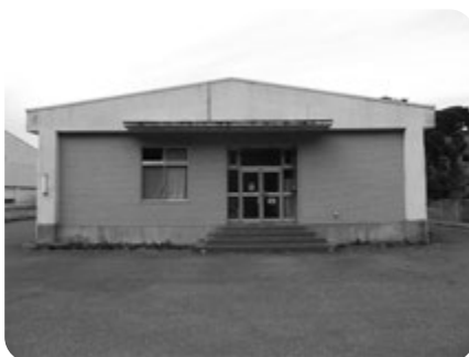
市内に3か所ある学校給食調理場を統合し、新たに共同調理場を建設する予定（写真：大貫共同調理場）
