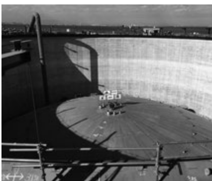
建設中のLNG貯蔵施設
