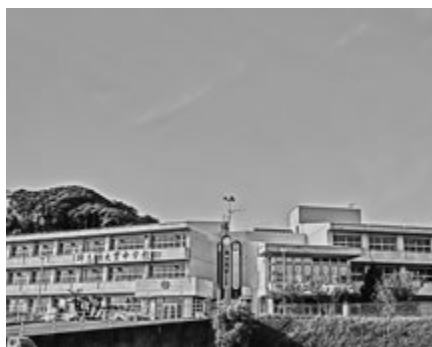
佐貫中との統合後に使用される予定の大貫中学校校舎
