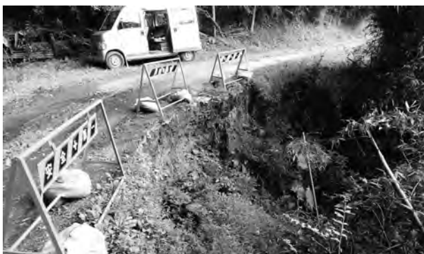
路肩崩落した市道高塚保釜線
