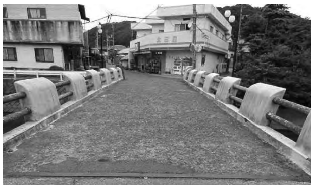
橋梁長寿命化修繕事業で工事予定の富士見橋（金谷）
