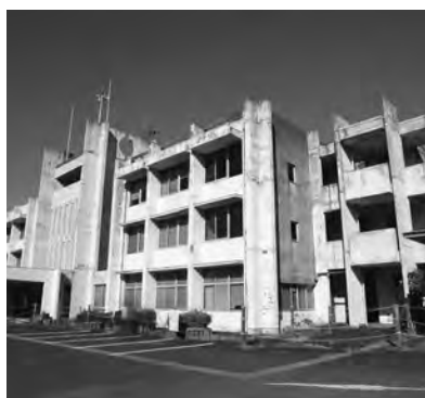
解体予定の旧天羽行政センター
