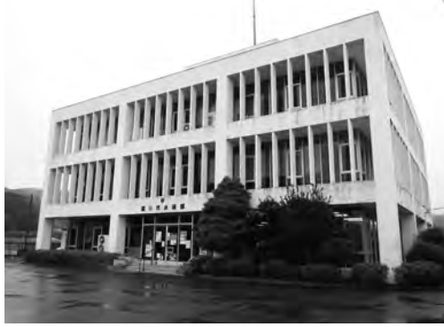
富津市亀田にある水道部の庁舎
