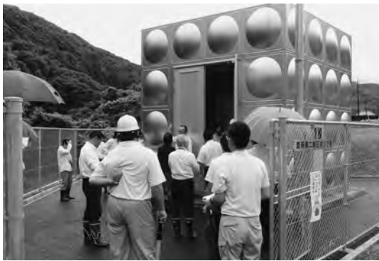
新設された豊岡第二増圧ポンプ場を視察
