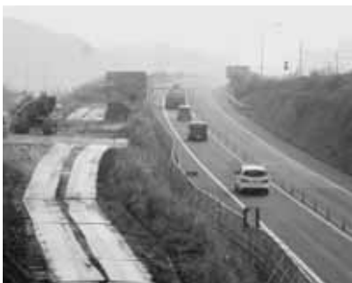
浅間山バスストップ計画地付近 館山自動車道(右側)工事用道路(左側) 2015. 12. 24 撮影
