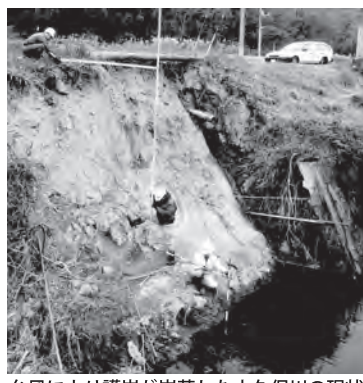
台風により護岸が崩落した小久保川の現状
