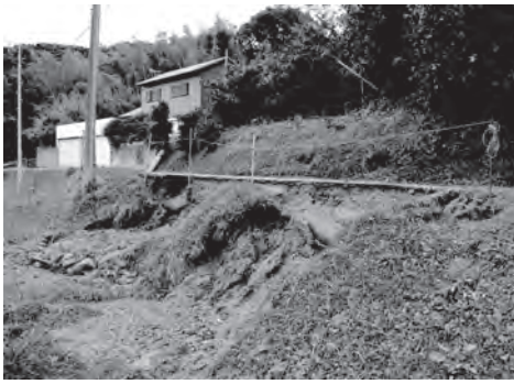
台風26号で、のり面が崩れた小久保地区の市道。市内の被害は甚大だった。
