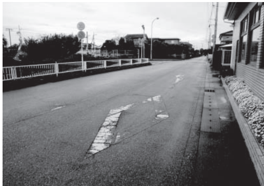
舗装修繕が行われる市道旧県道線
