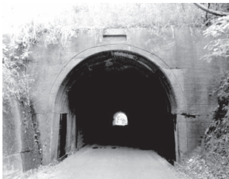
トンネルや道路の状況調査の必要性が高まっています。
