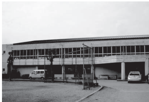
耐震補強工事が行われる湊小学校屋内運動場
