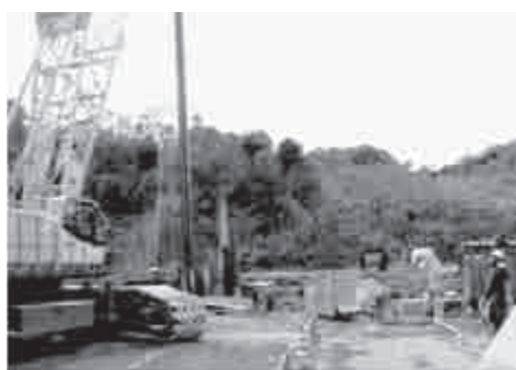
大平興産(株)第二処分場漏えい再策追加工事の矢板打ち込み工事=2012年12月20日
