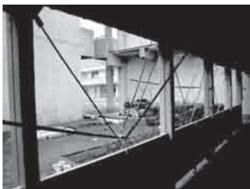
老朽化した小学校の渡り廊下
