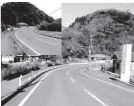
通学路合同点検後にガードレールが設置されました。
