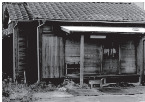
老朽化した空き家
