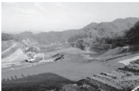
放射性物質に汚染された焼却灰等が埋め立てられている湊川上流の管理型最終処分場
