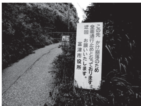
早期復旧が待たれる金谷大日隧道法面崩落現場
