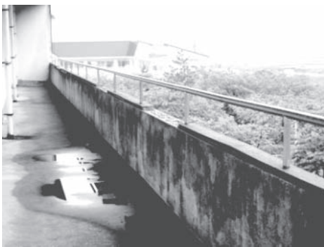
3.11の大震災で被害を受けた飯野小学校の様子
