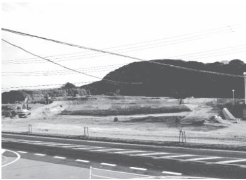
敷地（富津郵便局裏）造成の様子
