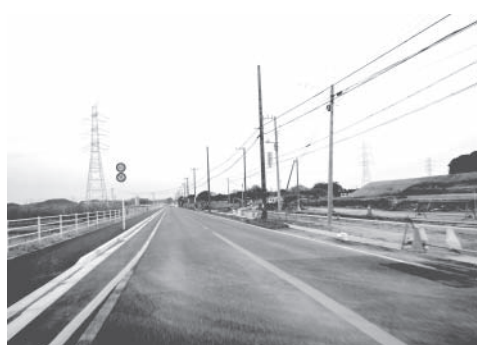
消防防災センター造成工事と今後の整備延伸が待たれる県道大貫青堀線
