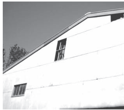
被害を受けた青堀小学校体育館の外装
