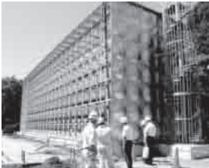
現地視察した大坪山配水池に築造されたステンレス配水池
