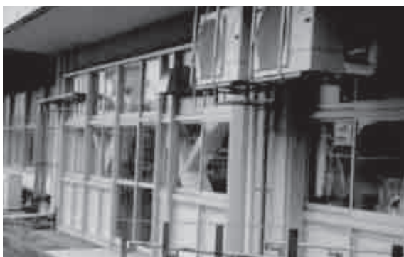
市内小中学校の耐震化工事が進められています。
