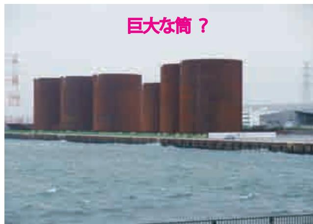
新富公共埠頭でつくられている巨大な筒。実は、岸壁の基礎として用いられる鋼板セル（鋼鉄製の円筒、直径 24.5m・高さ 32m）と呼ばれるものです。
