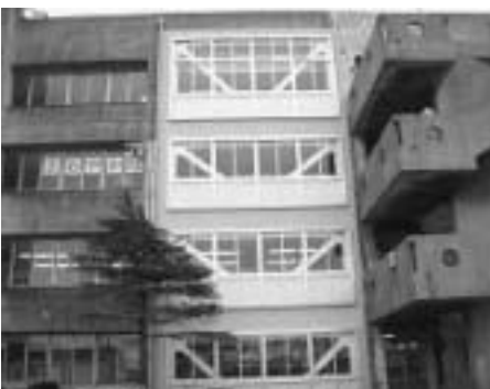
青堀小学校特別教室棟の耐震工事
