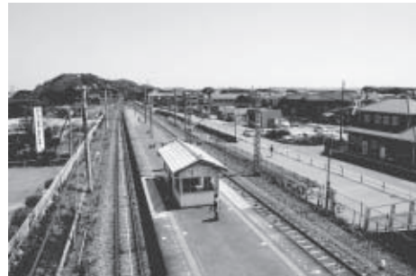
青堀駅・跨線橋から見た君津市方面
