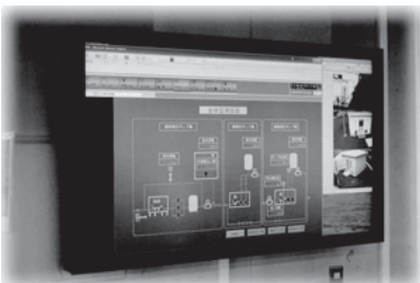
水道部に、現在設置されているテレメータ。新たに2カ所の配水池の表示が加わり、安全性が向上する
