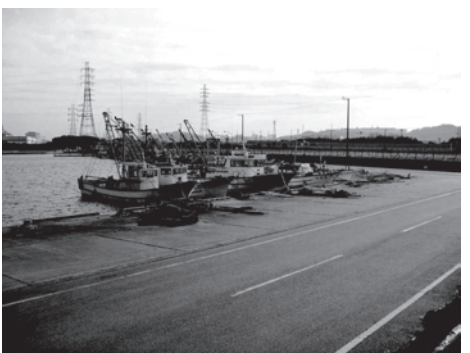
一般車両の乗入れや、無断駐車により作業に支障を来している小糸川漁港
