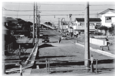
青堀駅東口で進んでいる道路改良工事。遠方に青堀駅の跨線橋が見える
