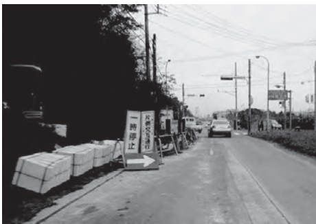
要望の多い道路整備の中で補修工事が行われた市道中上線
