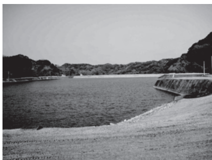
富津市水道部が管理している小久保ダム
