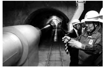
富津火力発電所が、平成15年から進めていた、神奈川県・東扇島火力発電所と富津を結ぶガス導管が、3月27日完成しました。
