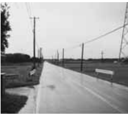
歩道設置が望める県道大貫青堀線
