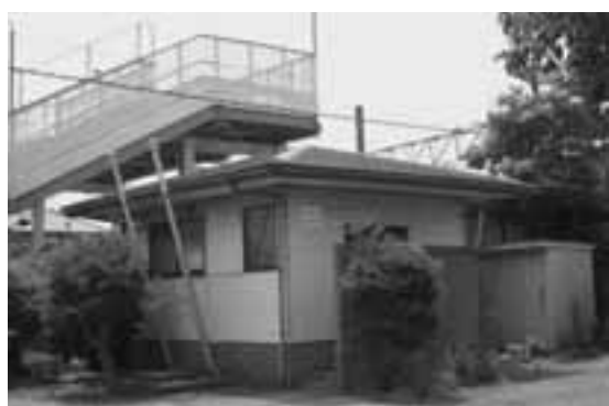
青堀駅トイレ
