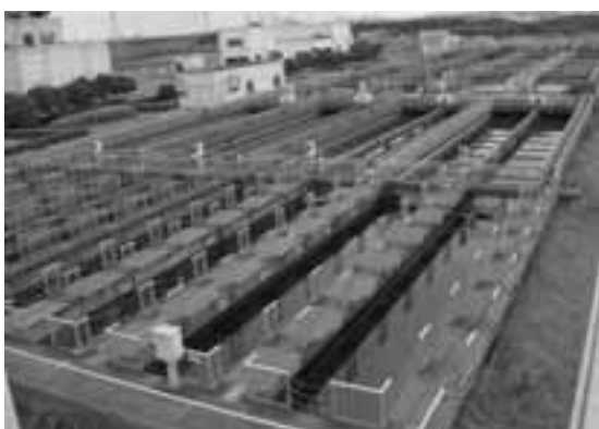
君津富津広域下水道組合下水処理場
