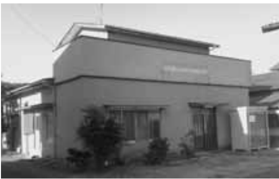
耐震診断が必要な佐貫青年館（収容避難所）
