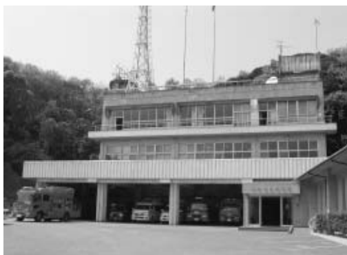
富津市消防本部庁舎
