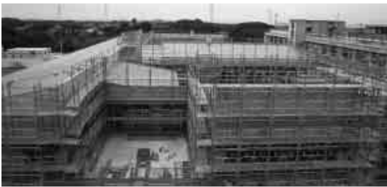
富津中校舎工事 全景
