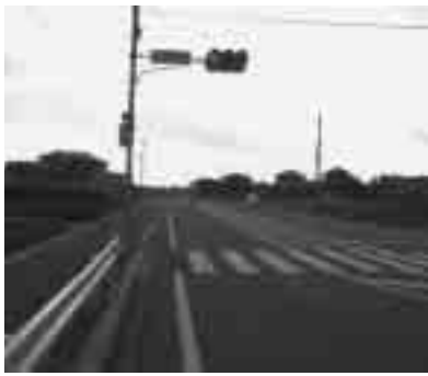
全面開通に向け整備が進められている都市計画道路川岸富津公園線
