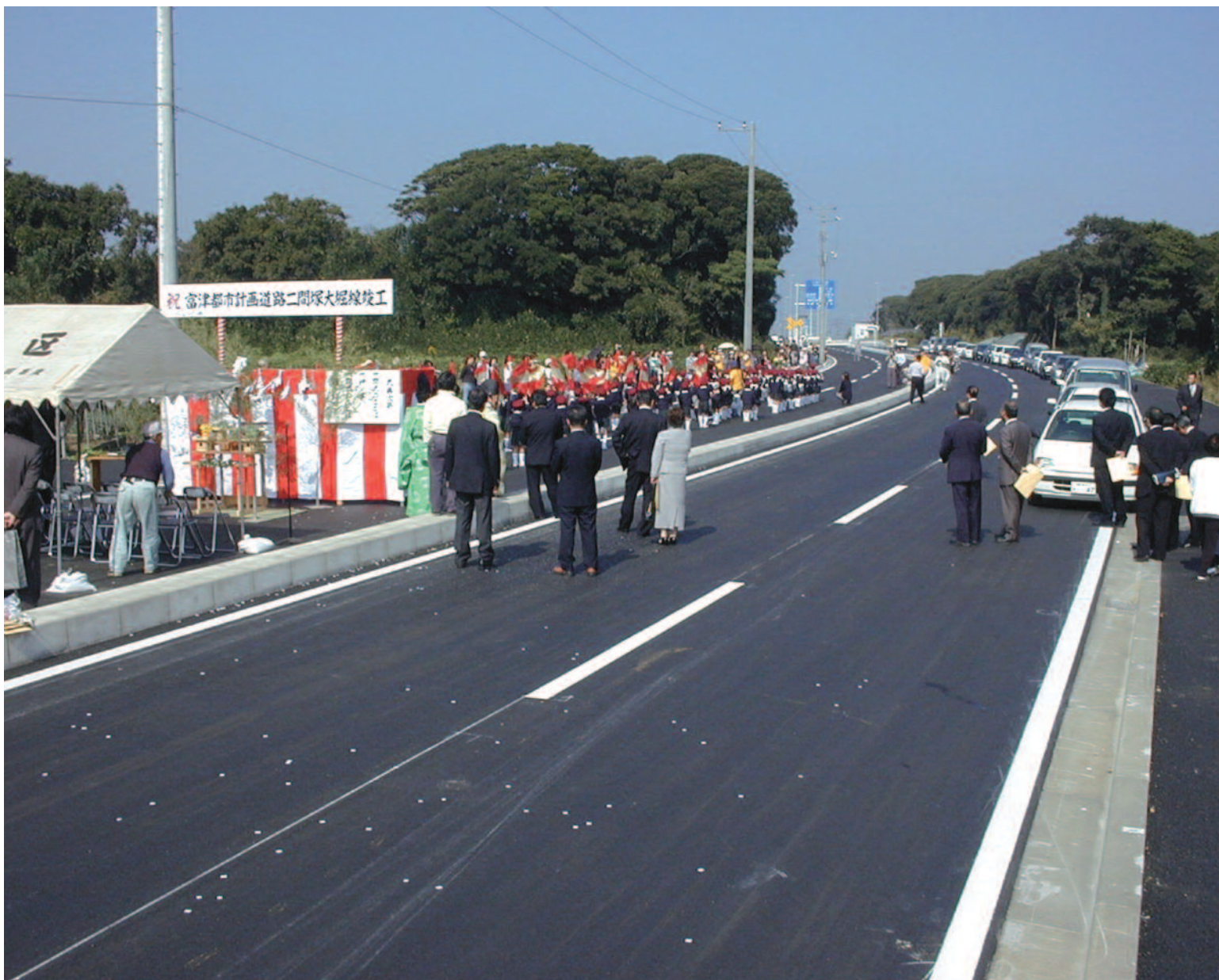
10月19日、晴天のもと「富津都市計画道路 二間塚大堀線」の竣工式が行われました。二間塚地域から大堀方面を見る。
