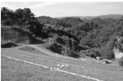
既に埋立が完了した大塚山第二処分場から下流側を見る。右下の四角い水槽近くの観測用井戸から、高濃度の塩化物イオンが検出された。
