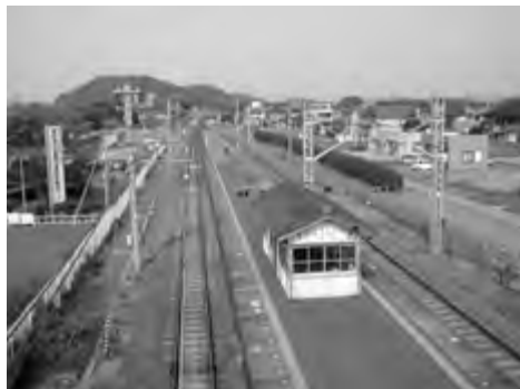
青堀駅の跨線橋から、君津方面のプラットホームを見る。この跨線橋の塗り替えも計画されている。
